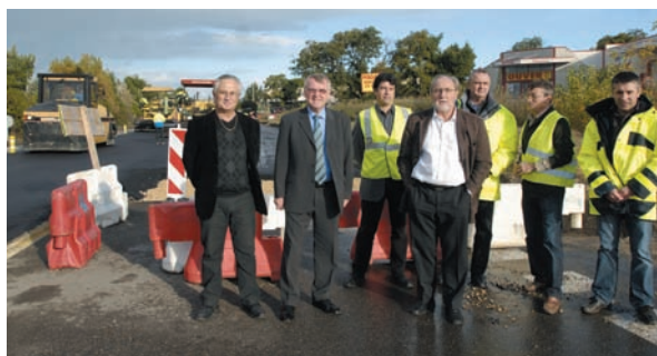
▲ Visite de chantier sur la RD 26 à Bollène. Les travaux devraient être terminés d'ici au début de l'année 2010.
