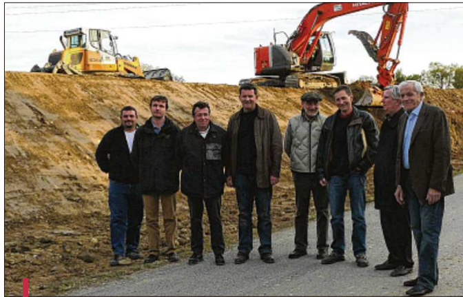
En décembre 2009, Maurice Lovisolo, conseiller général du canton de Pertuis et Gérard Barone en charge des routes au Conseil Général posaient fièrement sur le chantier de la déviation. /PHOTO ARCHIVES.I.T.
